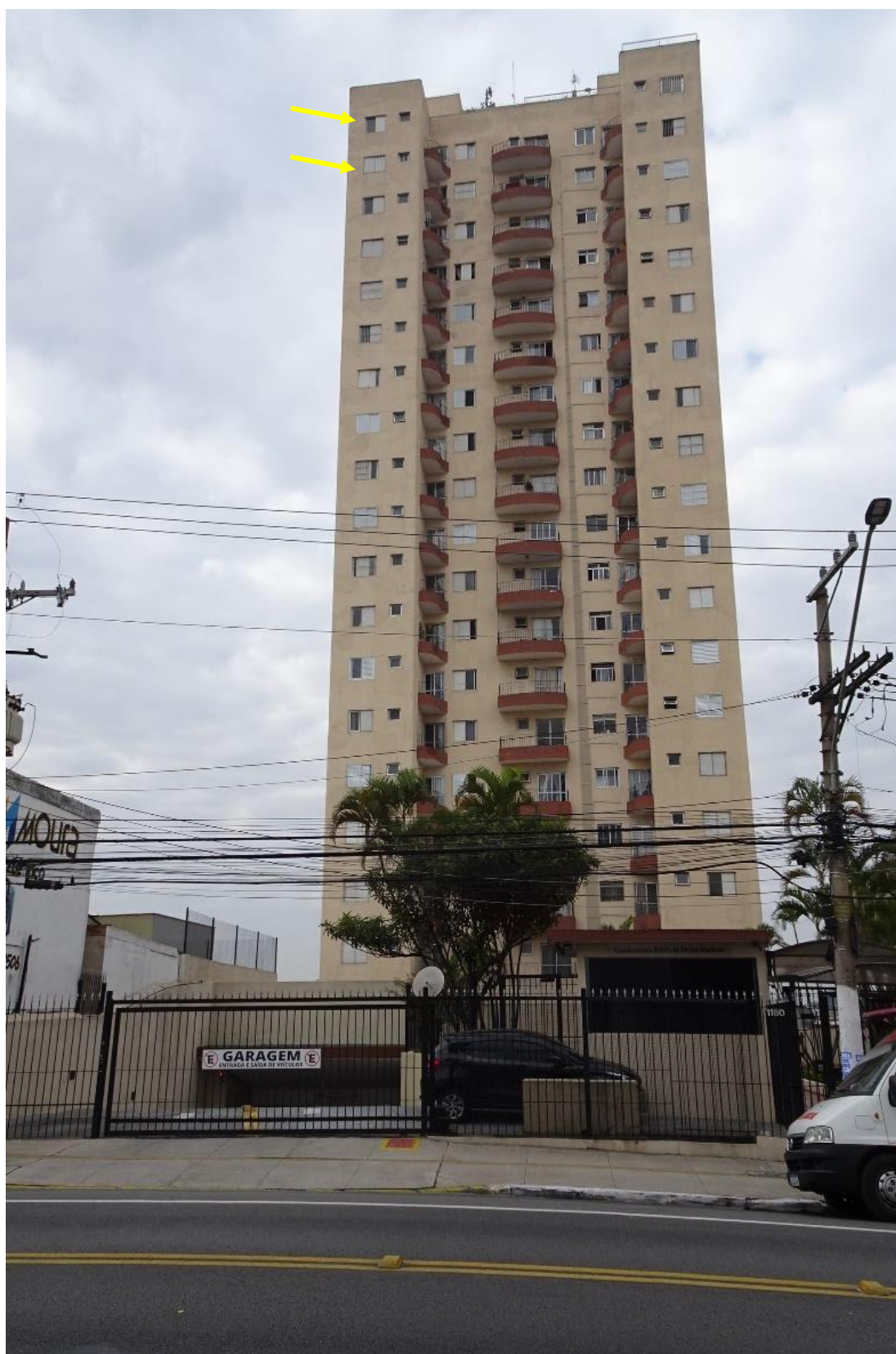
Foto 05: Fachada da frente do edifício e a localização do imóvel avaliando.
