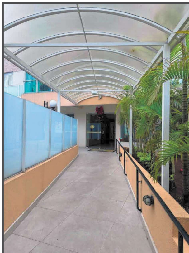
Foto 2: Vista parcial do hall social
