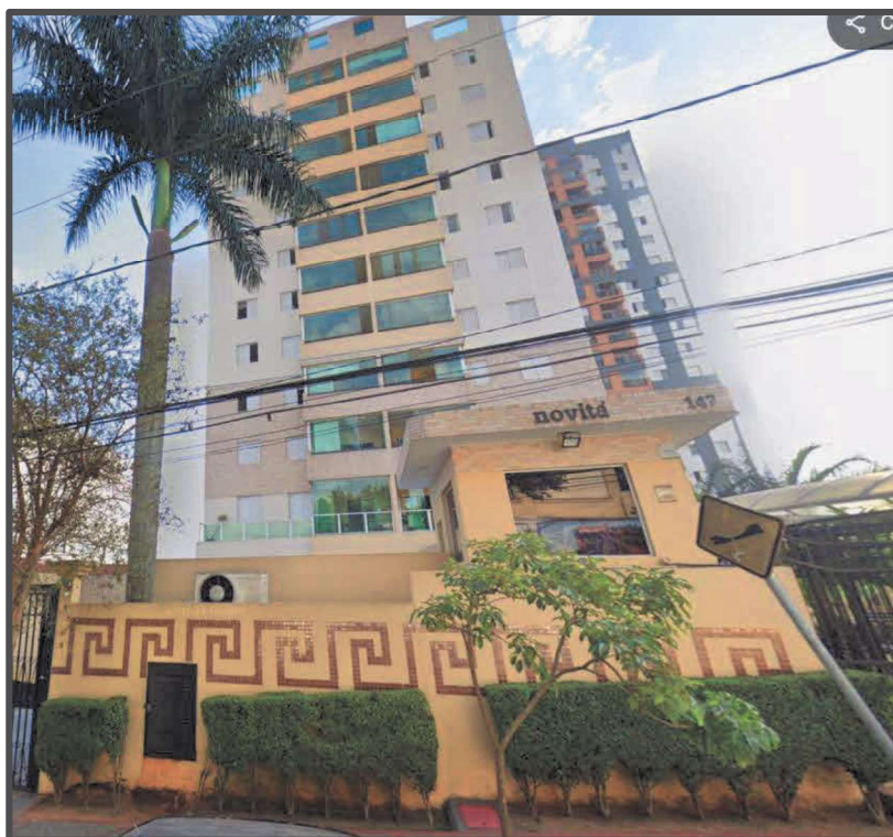
Foto 1: Fachada do Edifício
