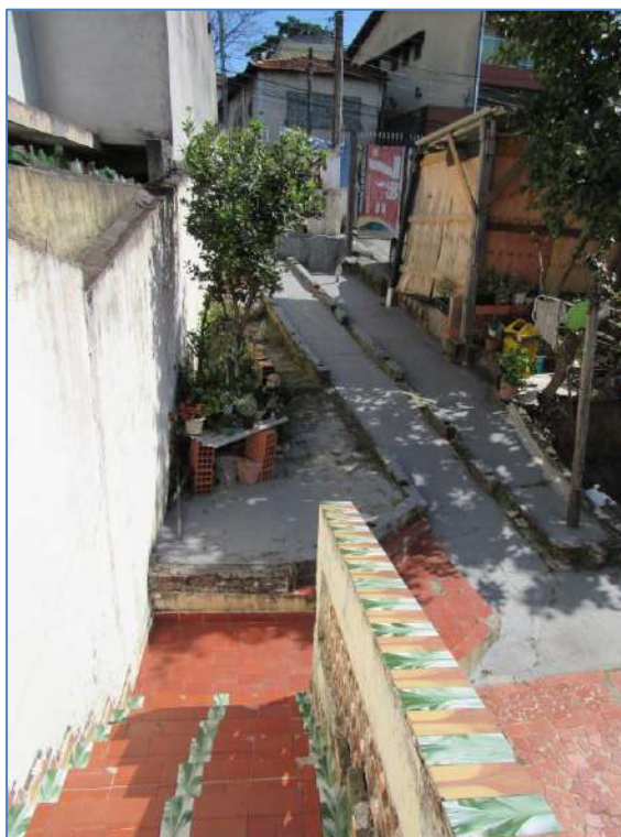
ESCADA DE ACESSO.
