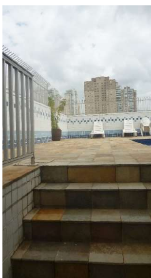
Escada para Piscina
