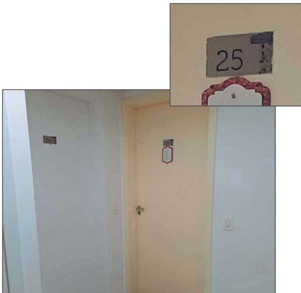
Fotos 21 e 22: Vista do hall do 2º andar. Destaque para porta de acesso ao apartamento nº 25.
