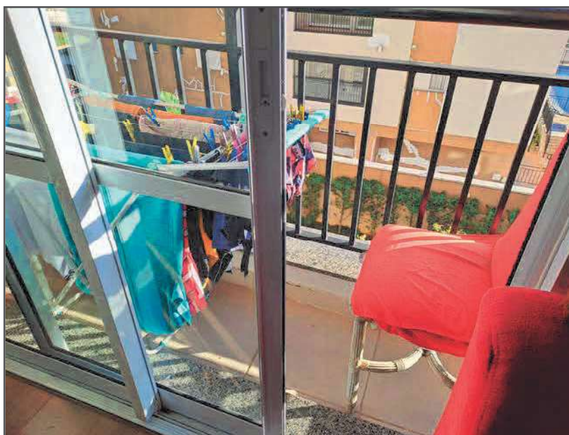
Fotos 31 e 32: Vistas das varandas.
