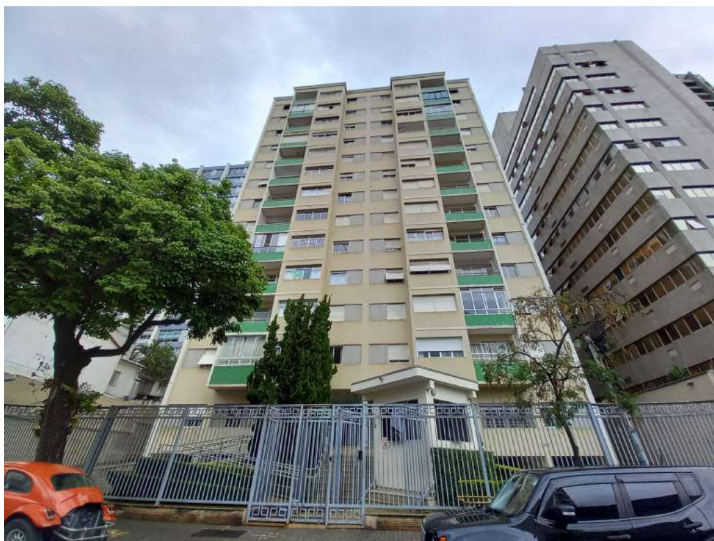
Acessos e Fachada do Prédio
