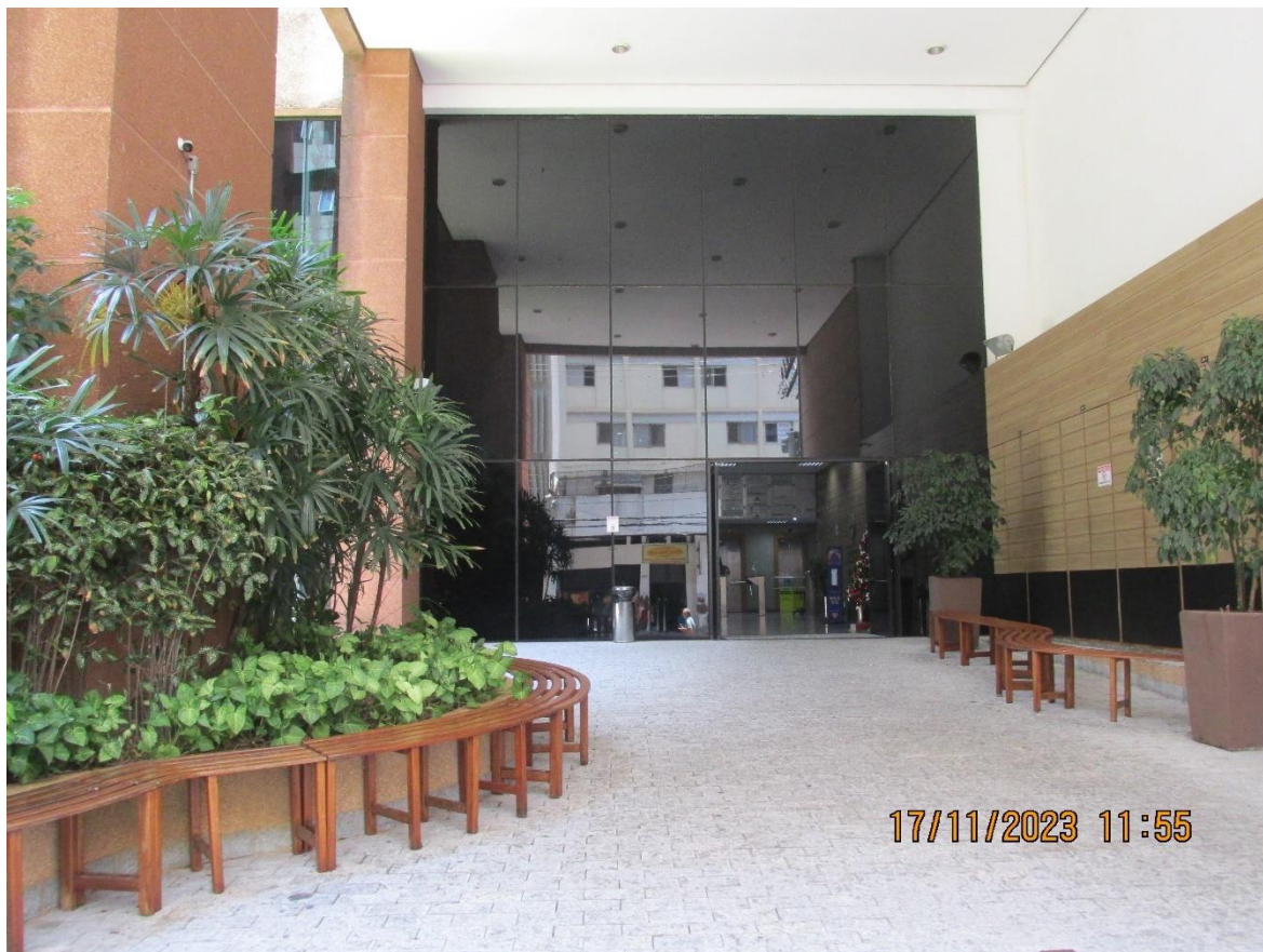
Fachada da Portaria
