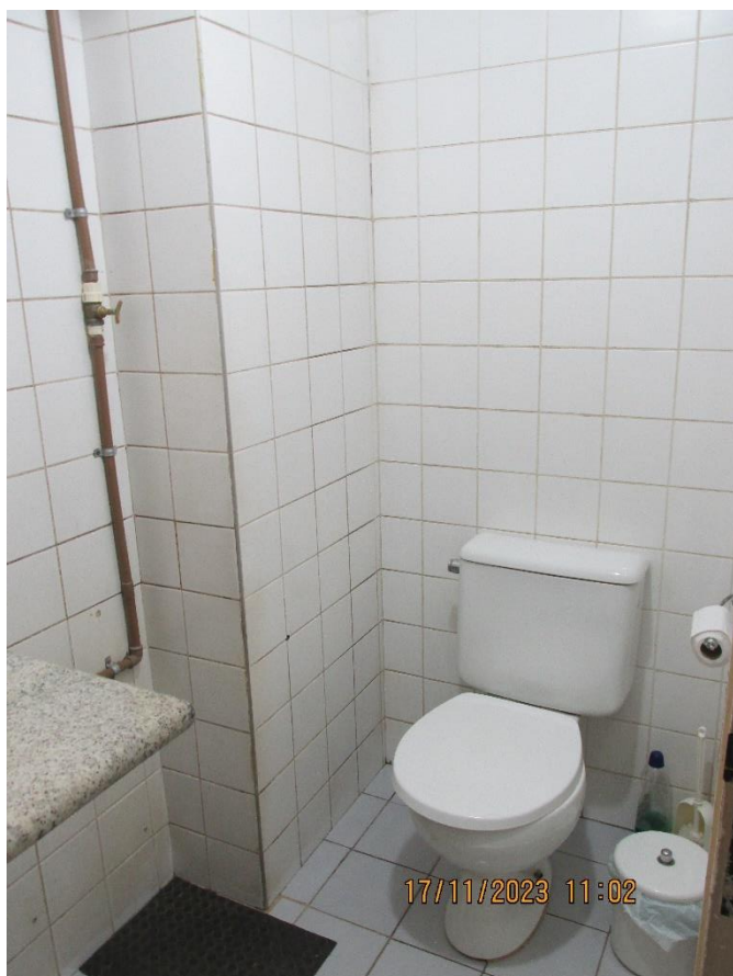
Banheiro (ângulo II)
