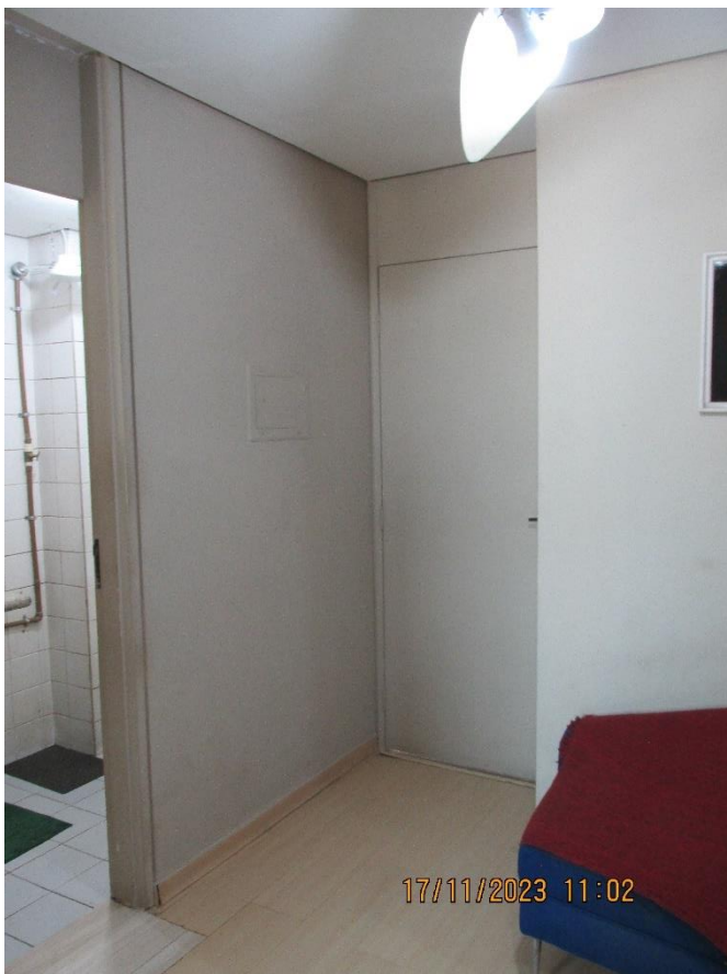
Sala Entrada/Recepção (ângulo III)
