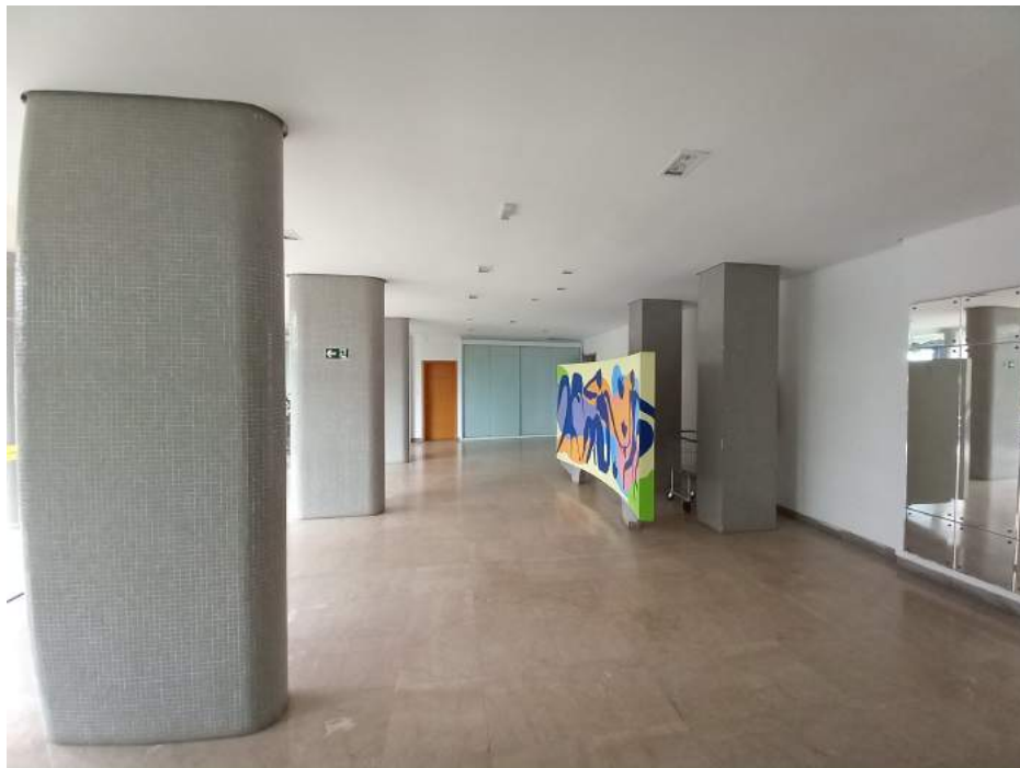
Hall de Entrada do Prédio – Pav. Térreo
