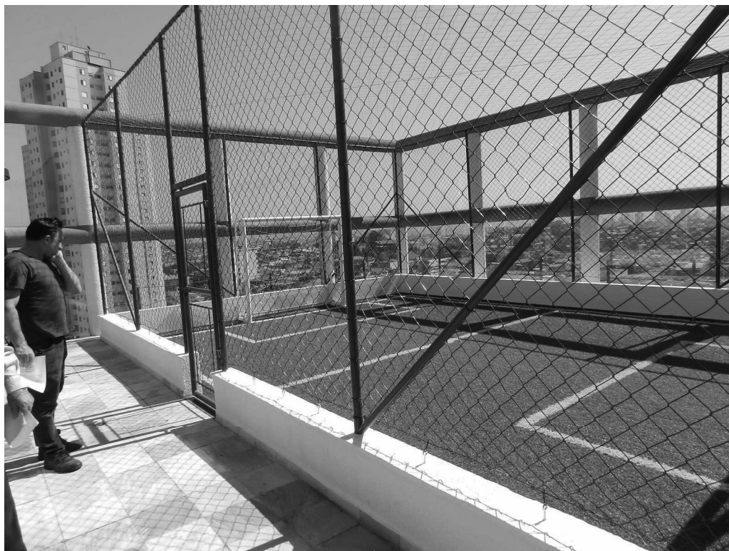
Foto 9 – Vista parcial da mini quadra poli-esportiva, localizada na cobertura do edifício.
