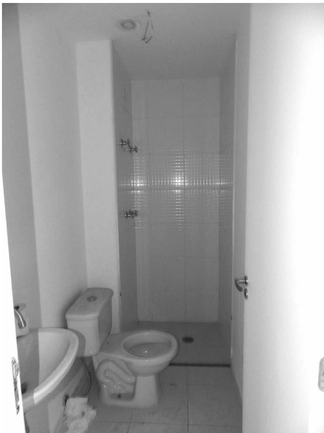
Foto 6 – Vista parcial do banheiro social.
