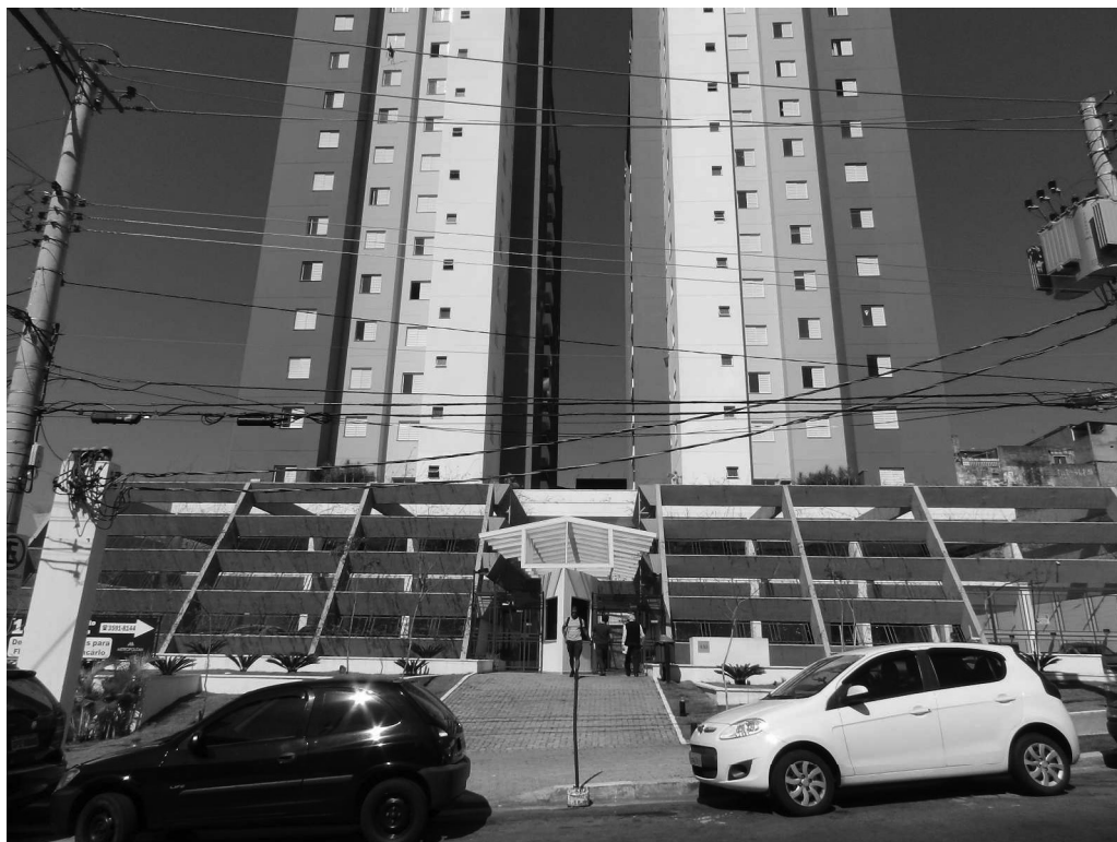
Foto 1 - Vista da fachada da do Condomínio.
