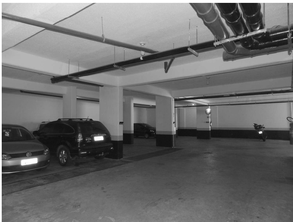
Foto 10 – Vista parcial da garagem em um dos 3 sub-solos.
