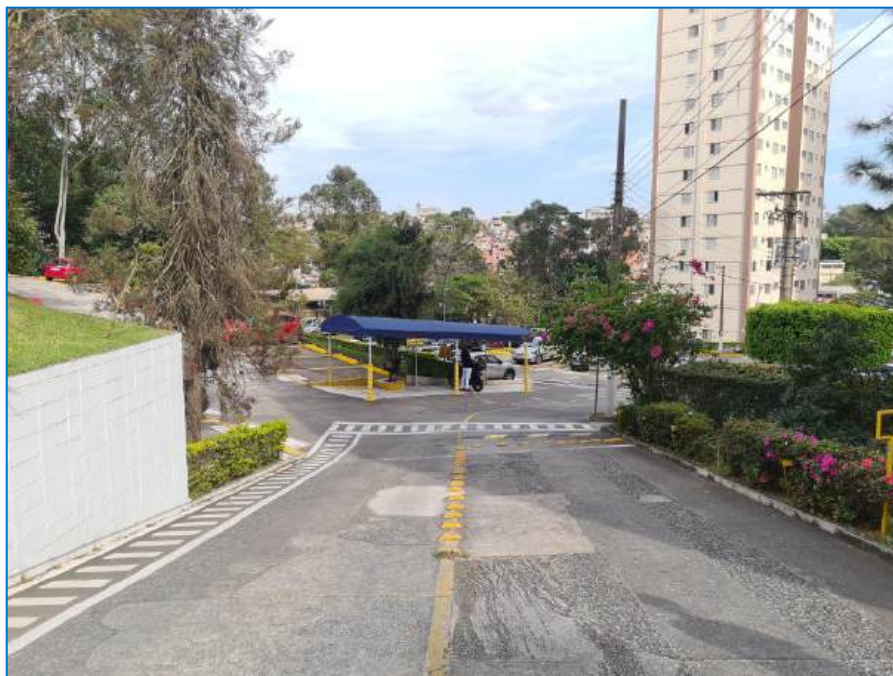
Foto de nº 09 - Sistema viário / rampa de acesso ao estacionamento.
