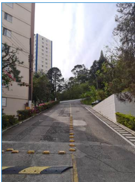
Foto de nº 10 - Sistema viário / rampa de acesso ao estacionamento.
