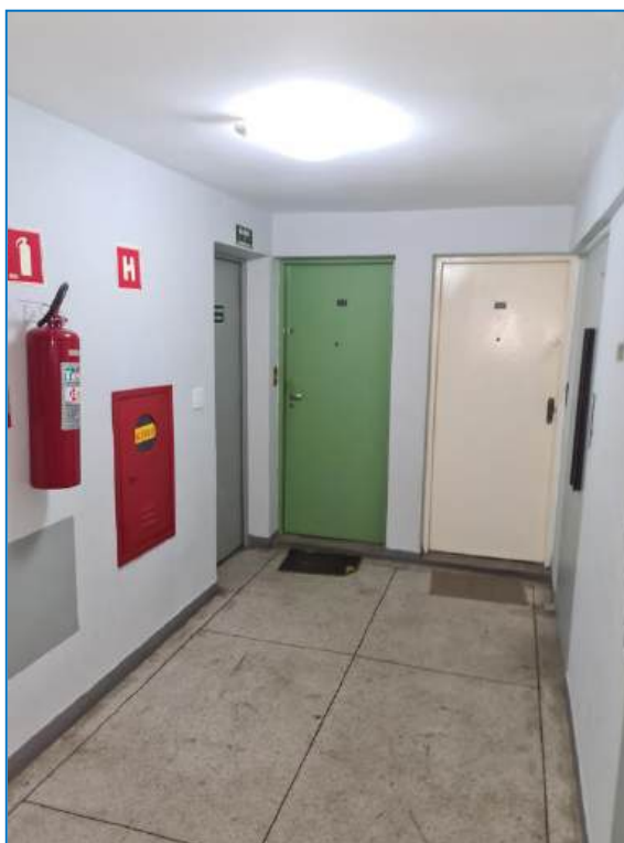
Foto de nº 29- Hall dos elevadores no 15º andar
