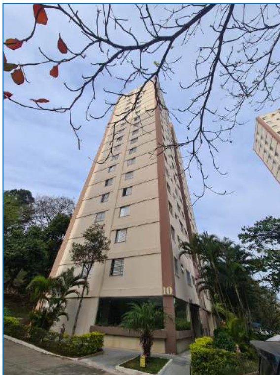
Foto de nº 25- Fachada do Edifício Ágata – Bloco 10.
