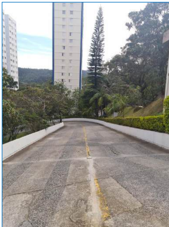
Foto de nº 07- Sistema viário / rampa de acesso ao estacionamento.
