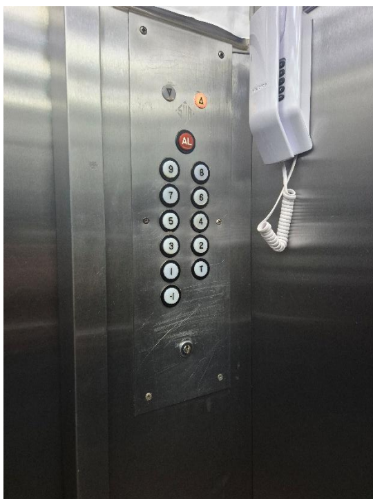
Elevador e entrada do imóvel avaliando.
